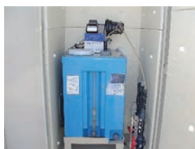
写真-2 油脂分解菌注入ポンプ
